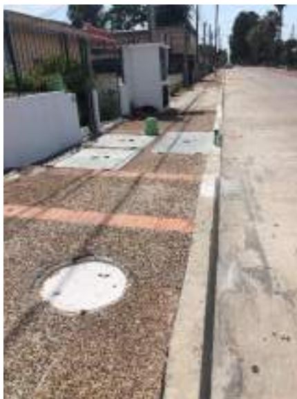
Figura 4-49: Tapas de pozo de bombeo.
