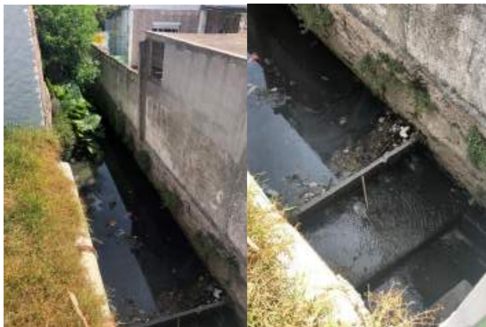
Figura 4-48: Cañada Pichuaga: zona canalizada entre las viviendas y captación con reja para el ingreso al pozo de bombeo.
