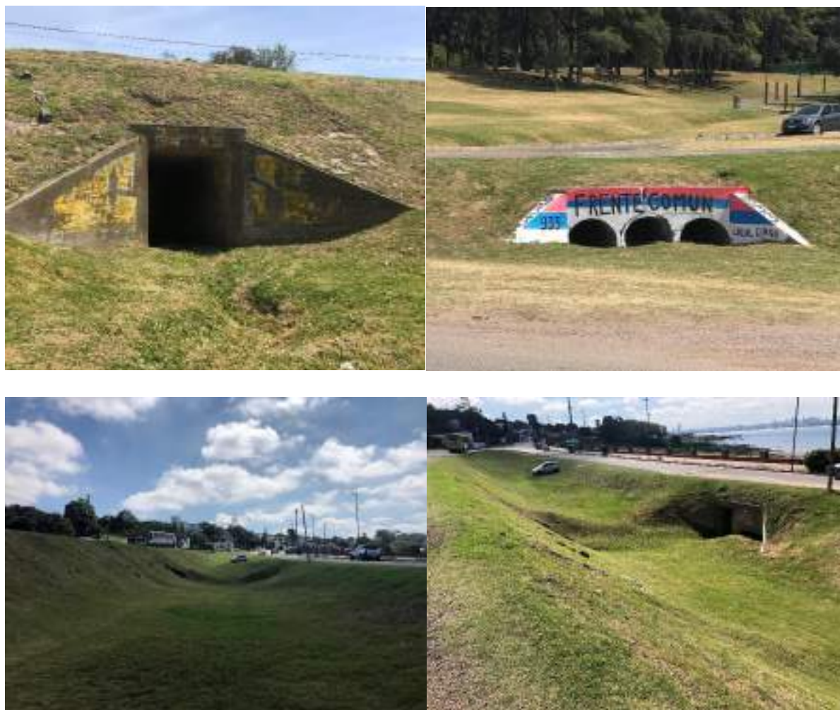
Figura 4-46: Alcantarillas de descarga en canalón.
