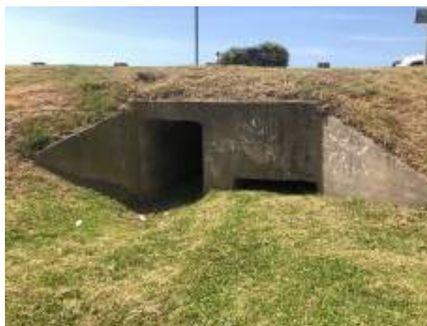
Cabezal de la descarga que vierte en la zona central de la playa.
