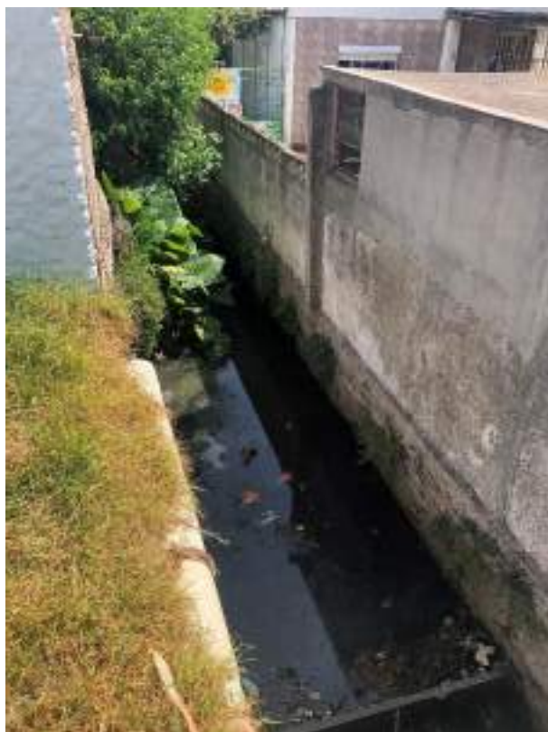
Cañada la Pichuaga: punto donde se captan los escurrimientos de la cañada hacia un pozo de bombeo, el cual bombea aguas residuales y de lluvia.
