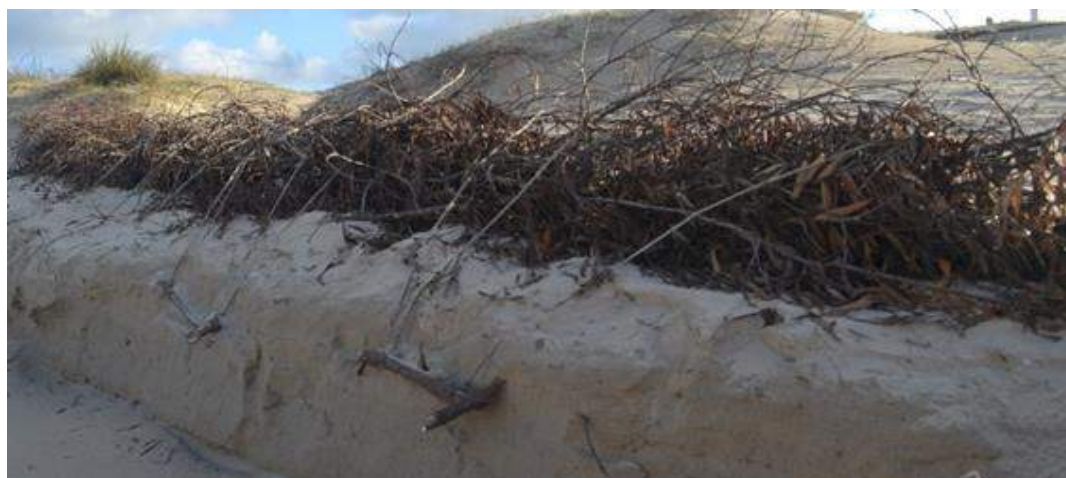
Figura 4-69: Corte de duna recuperada en experiencias anteriormente documentadas donde se aprecian anclajes y ataduras con hilo sisal.
