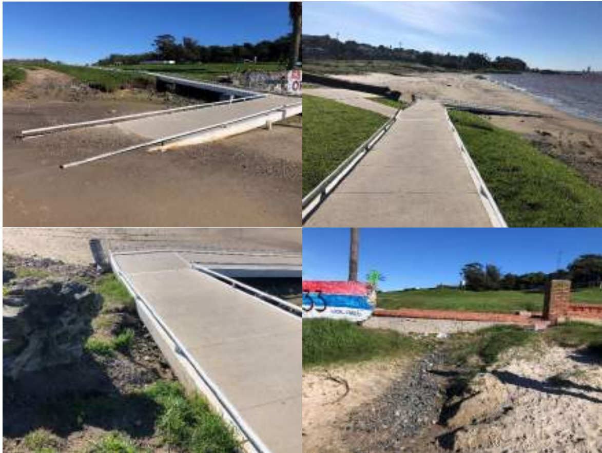
Figura 4-53: Rampa de acceso oeste, línea de puntos bajos en explanada empastada que descarga sobre la playa.
