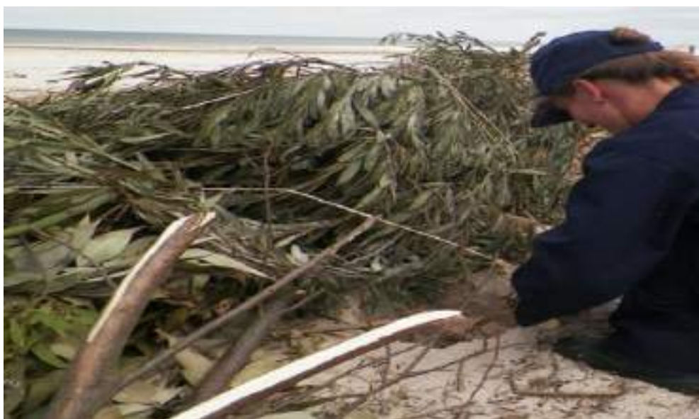
Figura 4-65: Atado de las podas y vista del detalle de cercas captoras (tomado de ficha técnica n°6 proyecto URU/07/2013)
